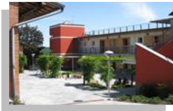
La Costa via Laghetto, 1 – Fino Mornasco (CO)
