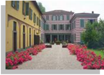
Monte Verde 1 via Strada Statale per Lecco,4 – Como
